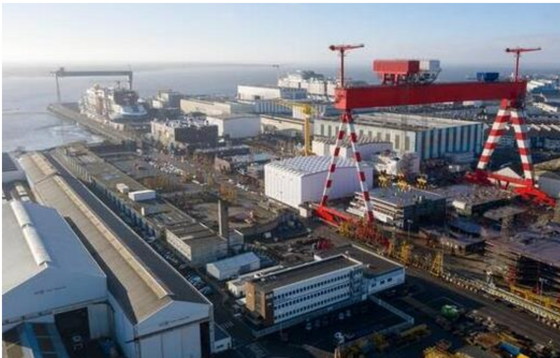
Vue des anciens ateliers de chaudronnerie Nord et du laboratoire au premier plan à gauche
