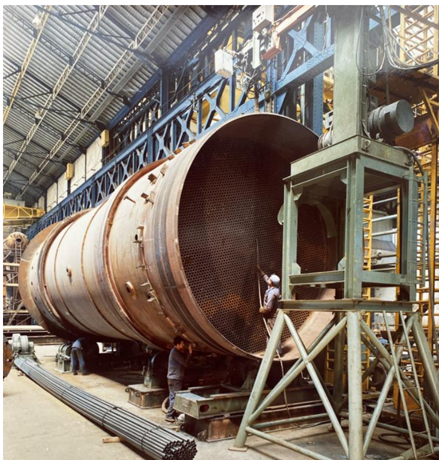
Vue d'ensemble d'une pièce chaudronnée en cours de réalisation Photo : collection AICCA
