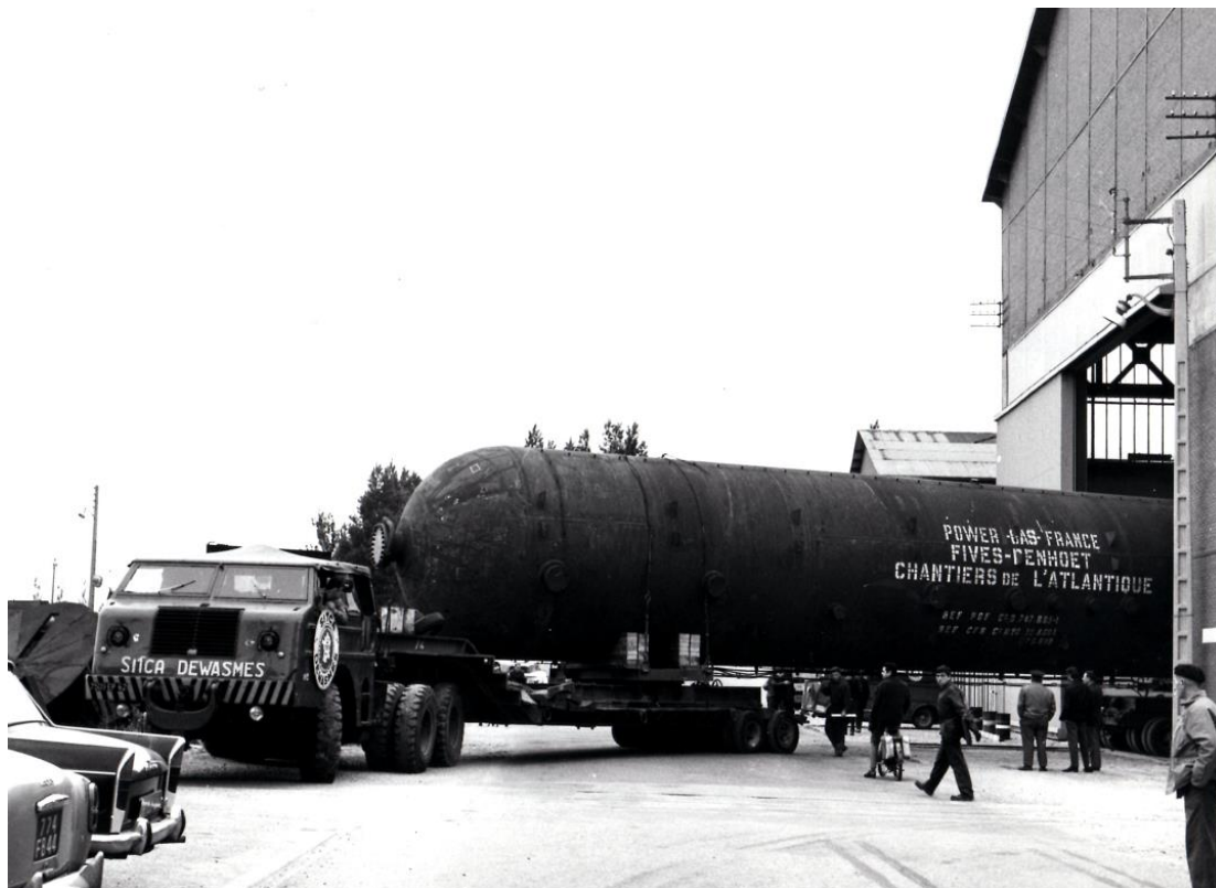
Transport d'un appareil chaudronné, sortie d'atelier
