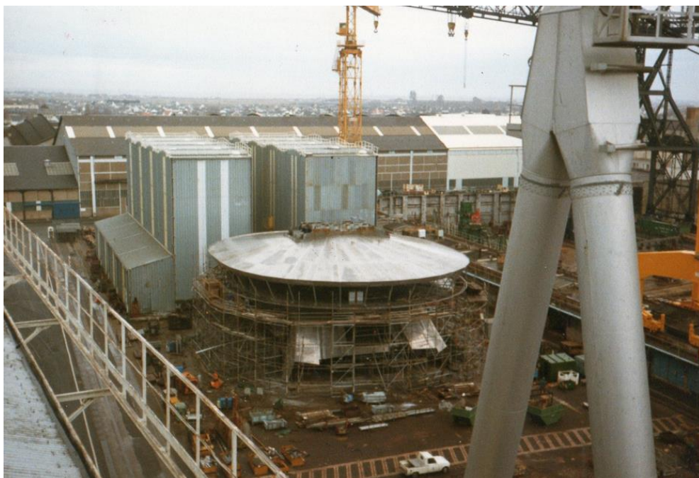
Les tours de bobinage
