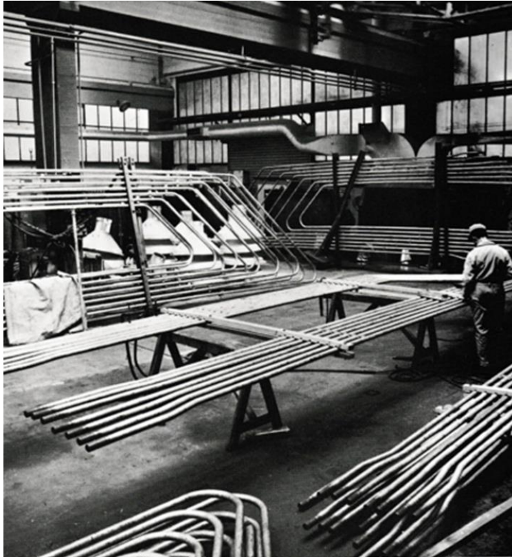
Faisceaux en acier austénitiques cintrés et soudés dans l'atelier chaudronnerie inoxydable Photo : revues ou bulletins techniques Chantiers de l'Atlantique
