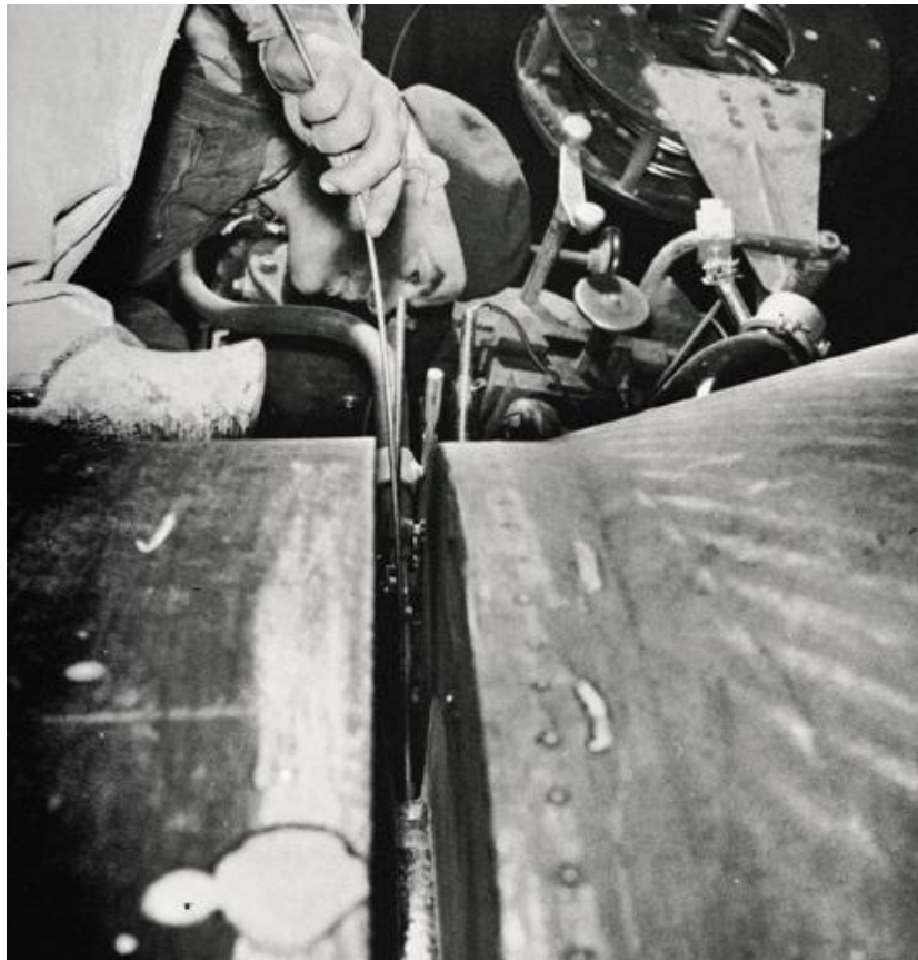
Soudure d'une bride sur un tube « Multiwall » Photo : revues ou bulletins techniques Chantiers de l'Atlantique
