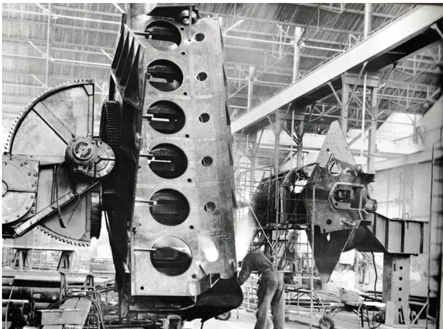
Bâtis de moteurs 12 PC2V sur positionneurs pour soudure des étriers de paliers sur les cloisons Photo : revues ou bulletins techniques Chantiers de l'Atlantique
