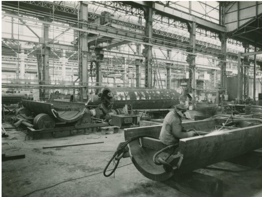
Soudure d'une pièce de chaudronnerie de la centrale de Montreau
