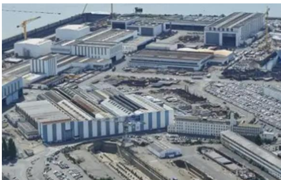
Vue aérienne : au premier plan vue d'ensemble de la chaudronnerie centrale
