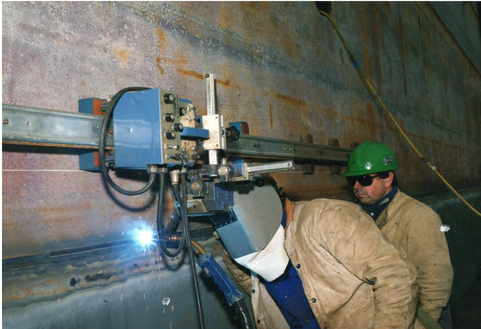
La mécanisation de la soudure sur les bordés
