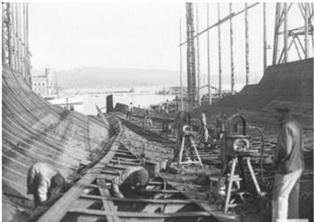
Travaux d'assemblage par rivetage
