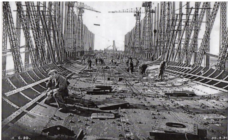
Assemblage du ballast
