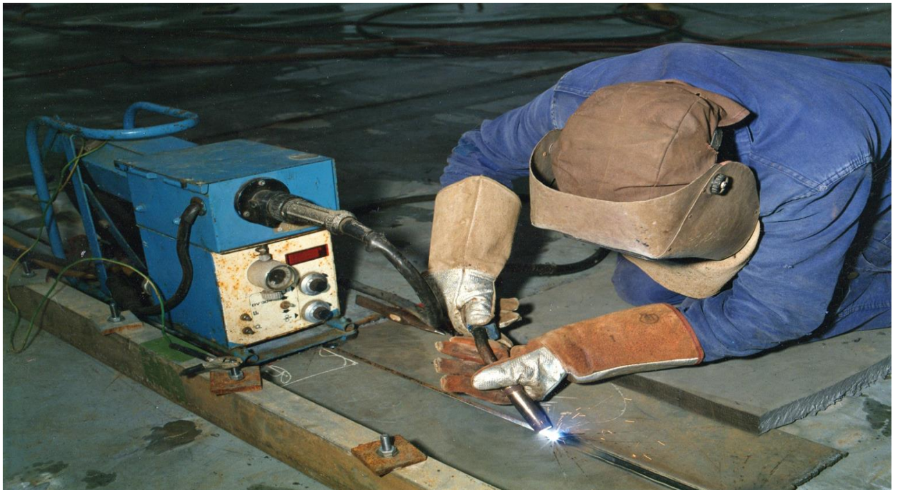
Soudure du joint avec le procédé Fil Fourré Avec Gaz
