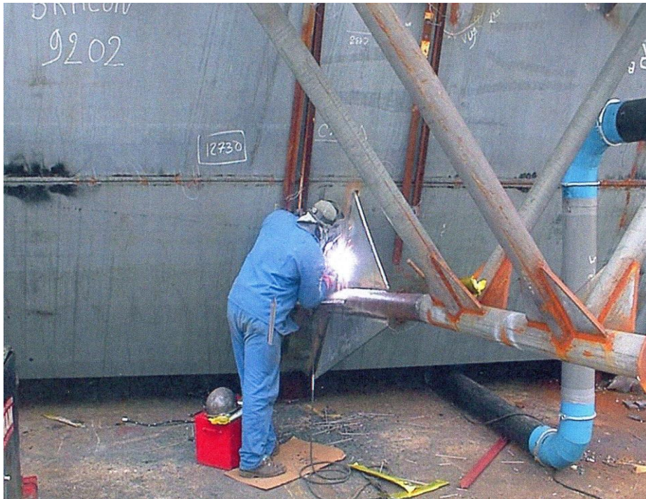
Soudure d'un « bracon »
