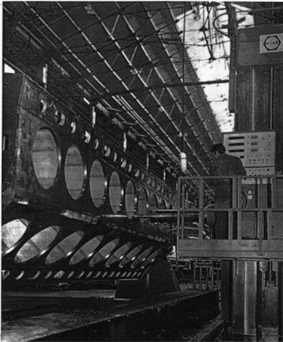
Section-Alésage EDLR à commande numérique usinée en bloc cylindric PC.1
