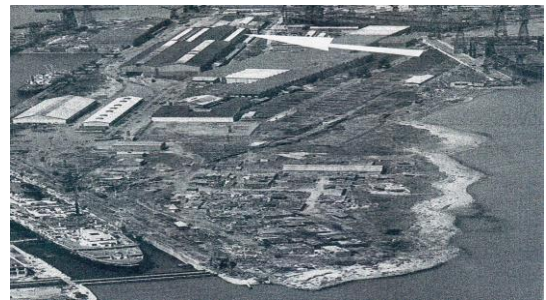
la tuyauterie des chantiers de Penhoët
