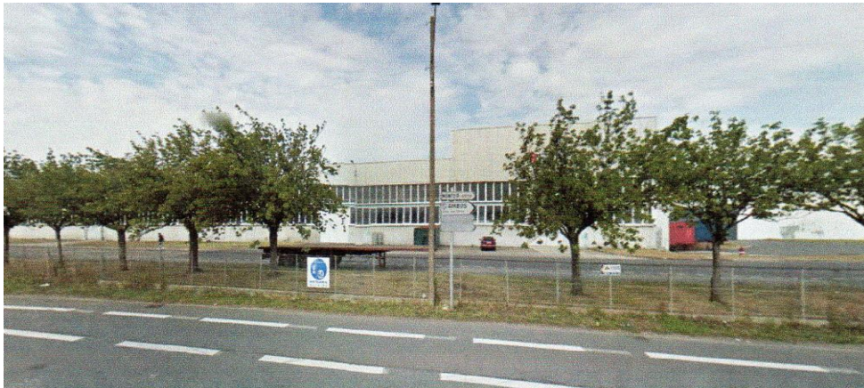
STX Cabins à Montoir
