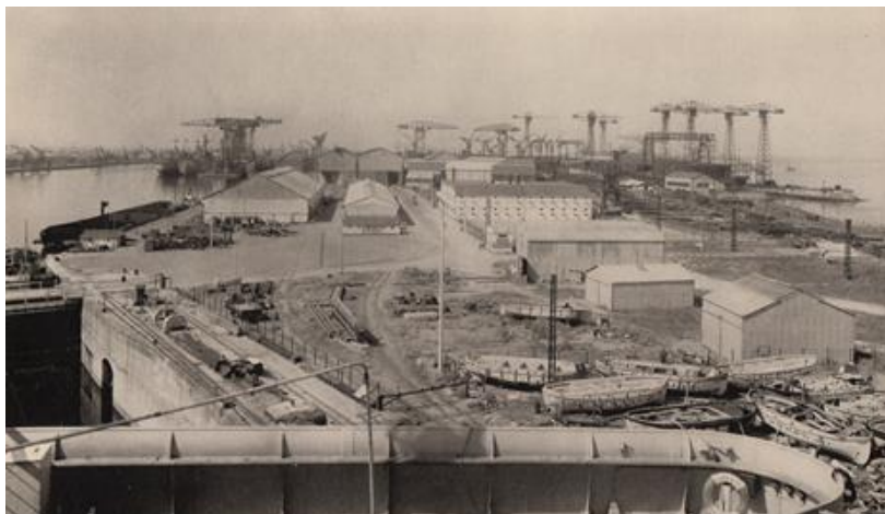
Ecole d'apprentissage des chantiers vue du paquebot Liberté
