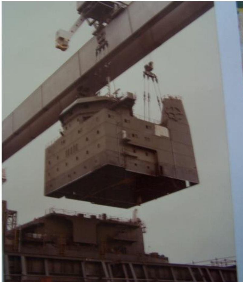
Pose des superstructures d'un porte conteneur DELMAS
