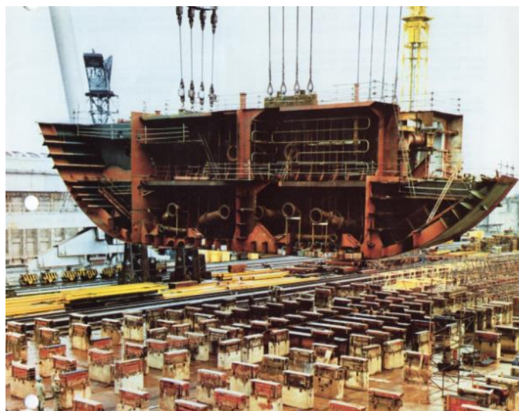
Pose d'un bloc sur les tins
