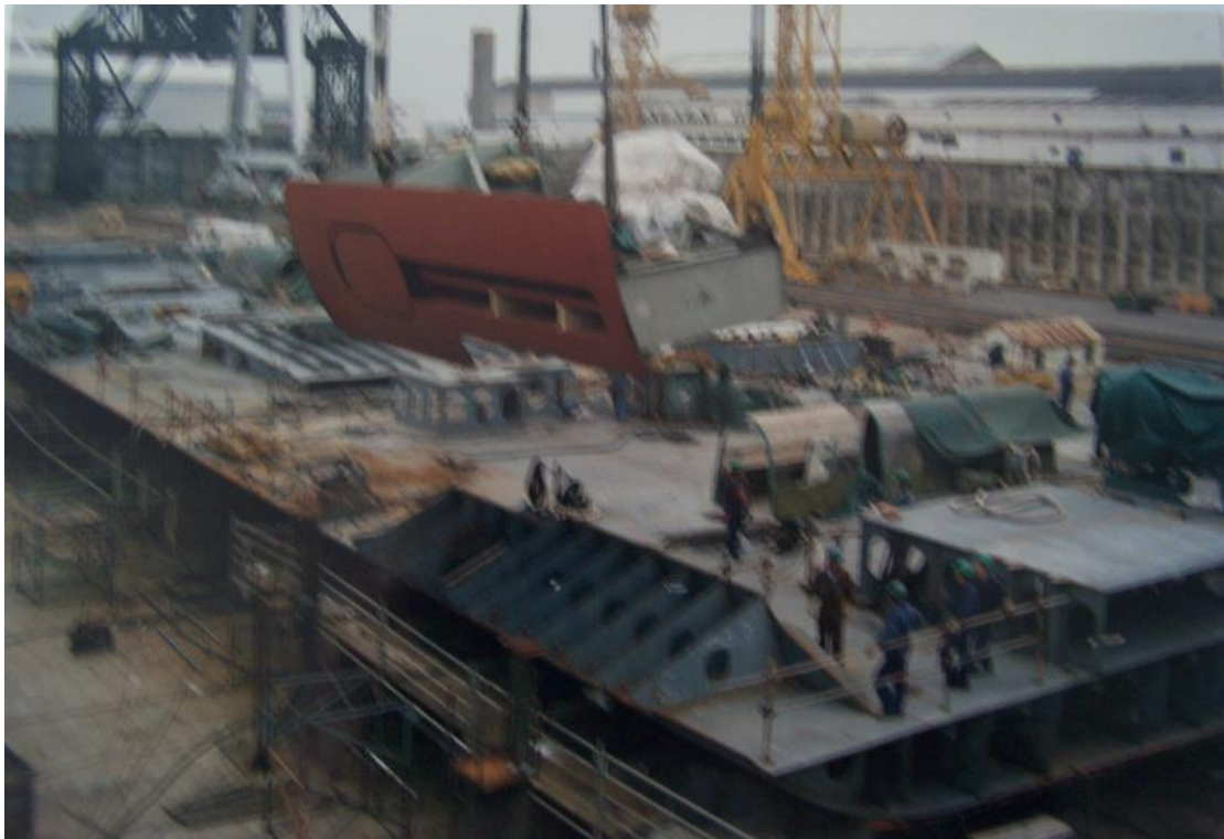
Pose d'un stabilisateur du Sovereing of the Seas
