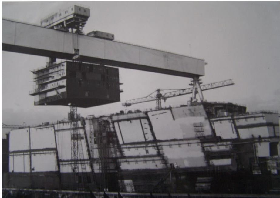
Pose de superstructures de pétrolier
