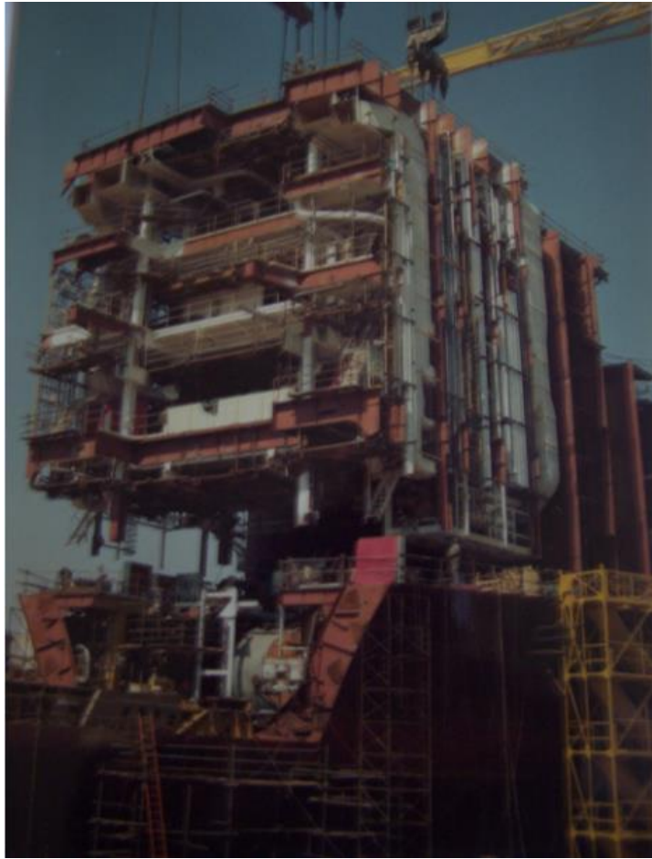
Montage du bloc machines d'un pétrolier de 500 000 tonnes
