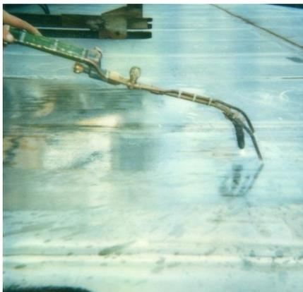
En effet, le soudage crée des tensions qui déforment les surfaces de ponts et de cloisons.
